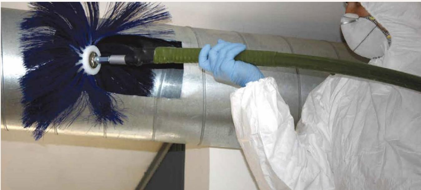
Valutazione, pulizia e ripristino dei sistemi HVAC (Heating, Ventilation and Air Conditioning), Ispezione e Sanificazione degli impianti Aeraulici **secondo lo standard internazionale NADCA** (National Air Duct Cleaner Association) e **come da Protocollo Operativo A.I.I.S.A.** (Associazione Italiana Igienisti Sistemi Aeraulici).
